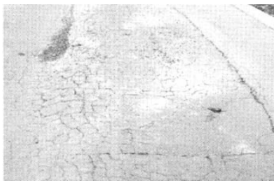
图1 国道318线康定~折多山段路面沉陷网裂
