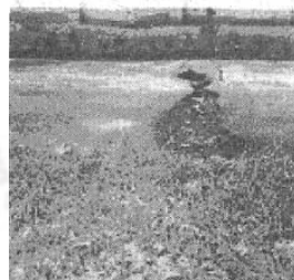
图2 路面的张拉破坏
