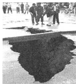
图1 地裂缝引起的路面塌陷
