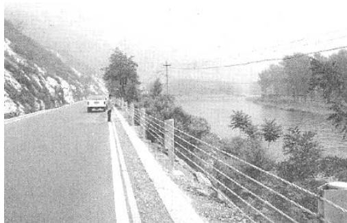
图2 国内安装的缆索护栏
