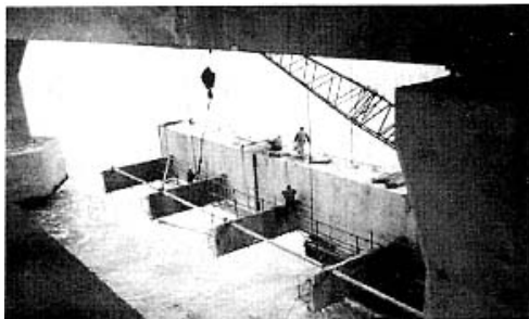
图6 逐段拆除钢主梁
