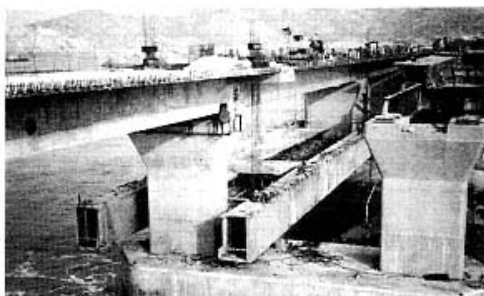
图5 移动模架整体落于桥墩承台上
