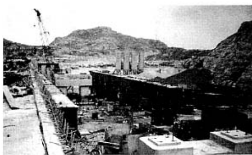
图2 移动模架的拼装
