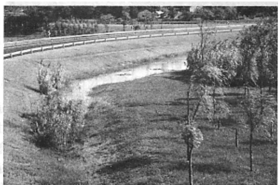
图 5 互通式立交内部边坡放缓,取消边沟
