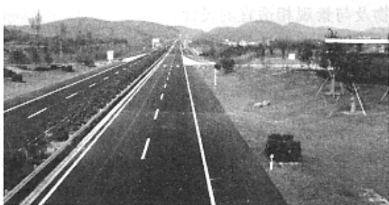
图 6 低填浅挖路段可取消路侧防撞护栏
