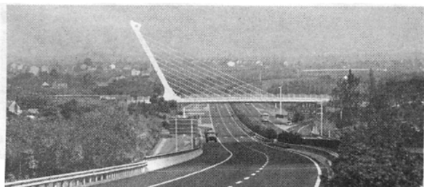
图4 单臂独塔斜拉桥
