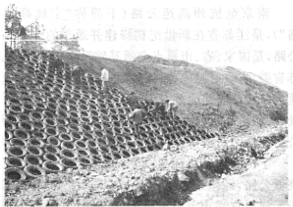
图3 废轮胎铺设时坡面
