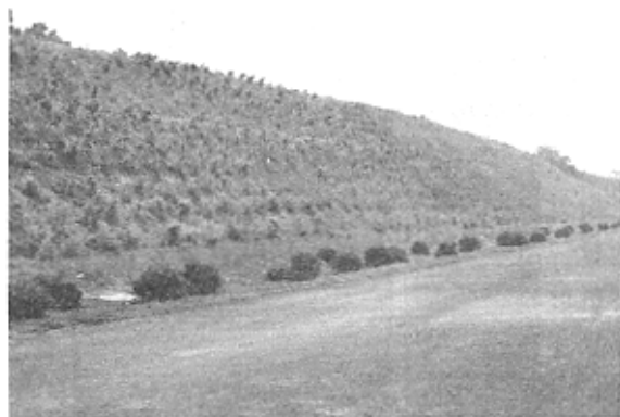
图 9 穴植技术防护坡面
