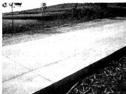
图 4 抛石水泥混凝土路面外观
