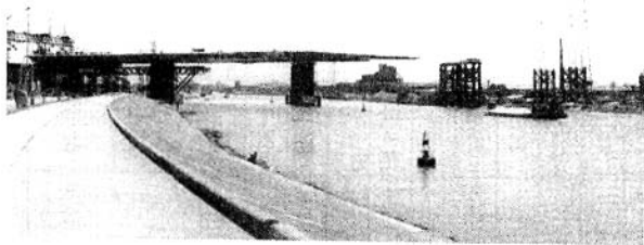
图3 顶推法架设钢箱梁
