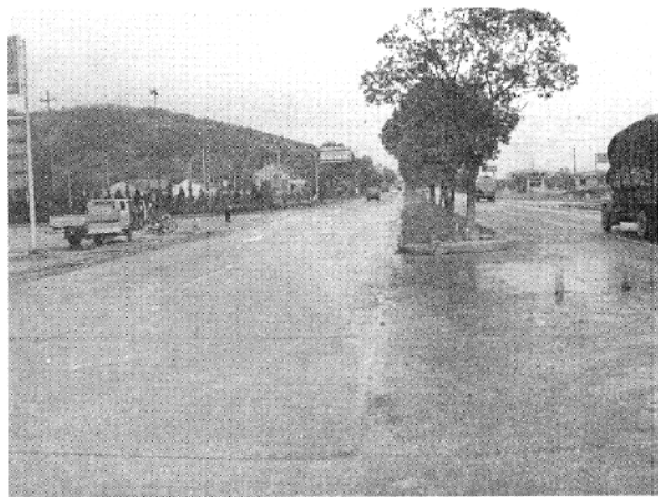
图 7 影响视距和产生投影的中央分隔带植树
