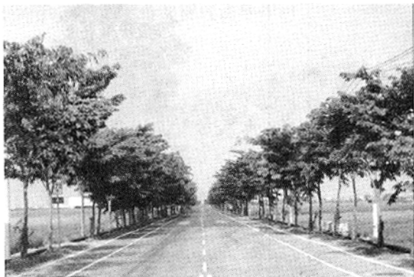
图 8 加重事故后果和产生路面投影的路侧栽植
