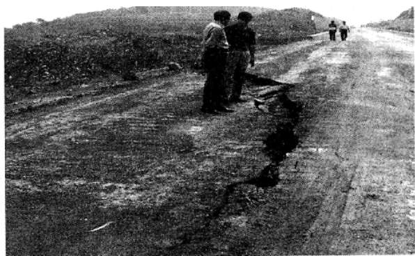
图2 滑坡顶面张裂隙
