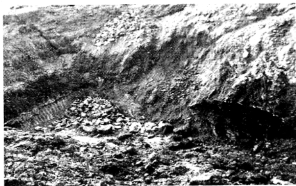
图3 填方坡脚滑动面开挖
