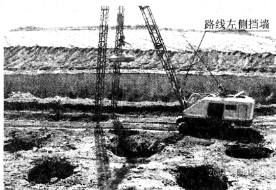
图 9 强夯法加固路堑填方
