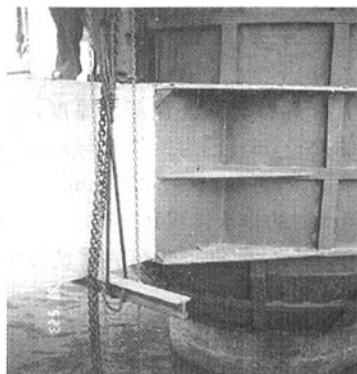
(2) 系梁与套箱相接细部构造
