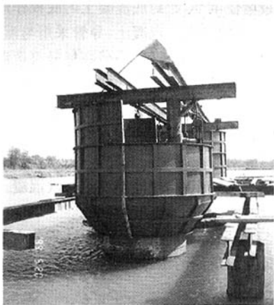
(3) 套箱左右两半接缝
