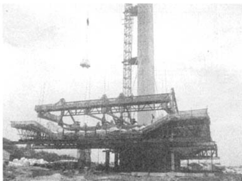
图8 现场砂袋预压照片
