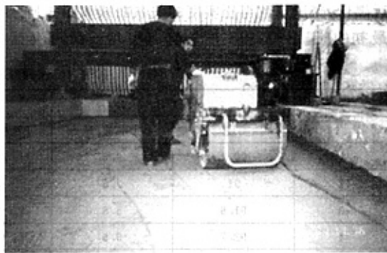
图 1 手扶式振动压路机振动压实
