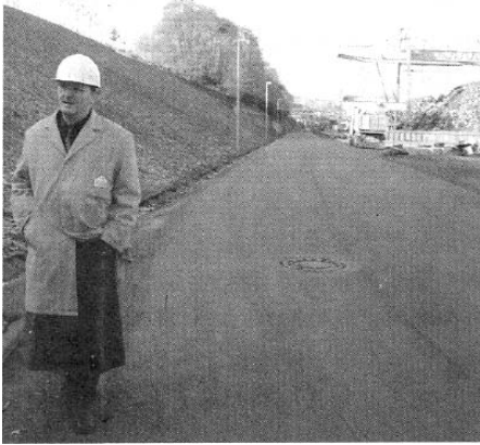
图 5 图林根钢厂用钢渣修筑的厂区运输用沥青结合料路面
