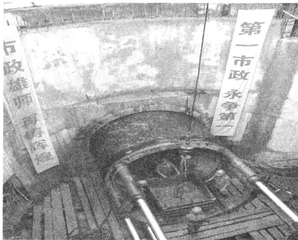
污水治理三期 1.5 标长距离曲线顶管实现地下十字对接
