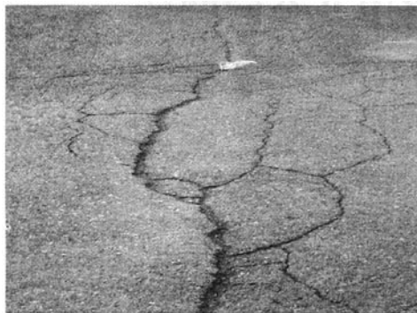
图1 严重裂缝伴沉陷病害
