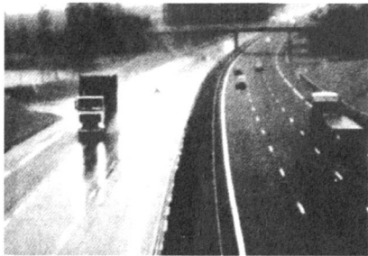
图 3 普通沥青路面与胶粉改性沥青路面雨后对比
