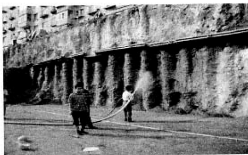
图 1 锚喷细石混凝土施工
