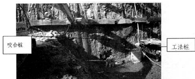
图 7 咬合桩咬工法桩后成桩
