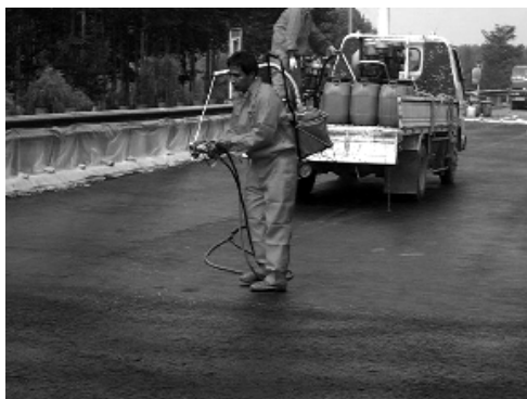
图 2 带纤维同步喷涂
