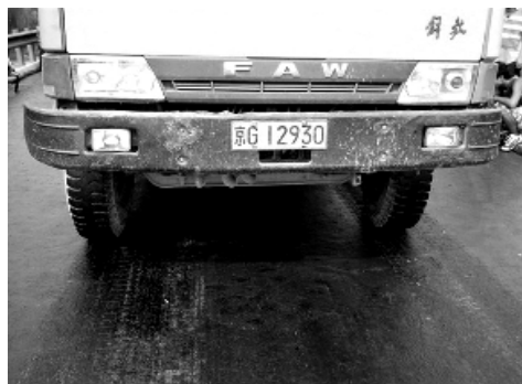
图 4 防水层经车辆碾压情况
