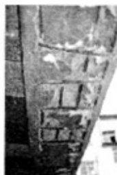
(b) 工字梁梁底露筋
