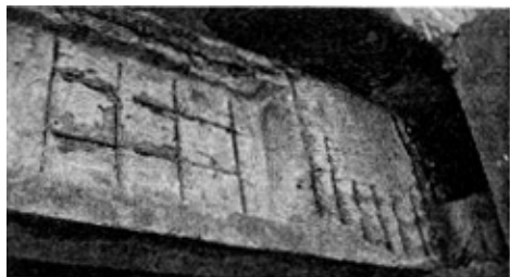
(a) 工字梁侧面露筋
