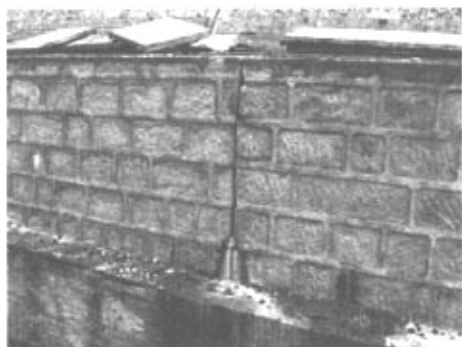
图 3 挡土墙沉降缝排水的情况
