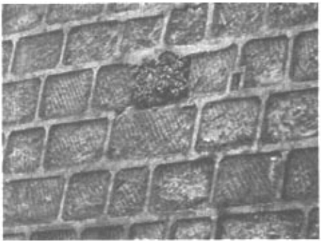
图 4 挡土墙用无砂混凝土作泄水孔
