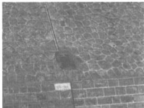
图 8 泄水孔出口设花台的情况
