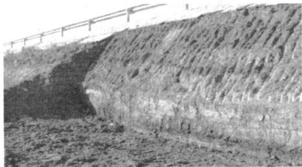
图 2 安新高速扩建工程开挖时路基保持稳定
