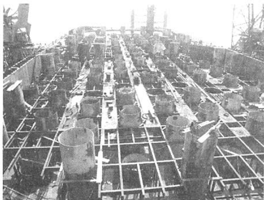
图7 钢吊箱现场拼装
