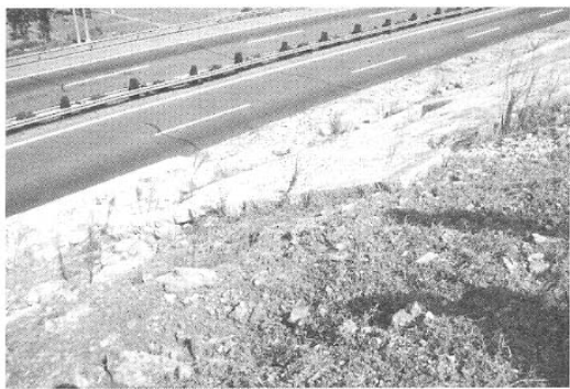
图2 坡面浆砌块石滑动
