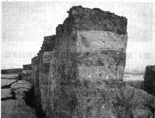
图 4 路堤右半幅滑坡使路边鱼塘底部露出水面
