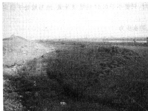
图 3 路堤左半幅滑塌使稻田抬高 2 m 多
