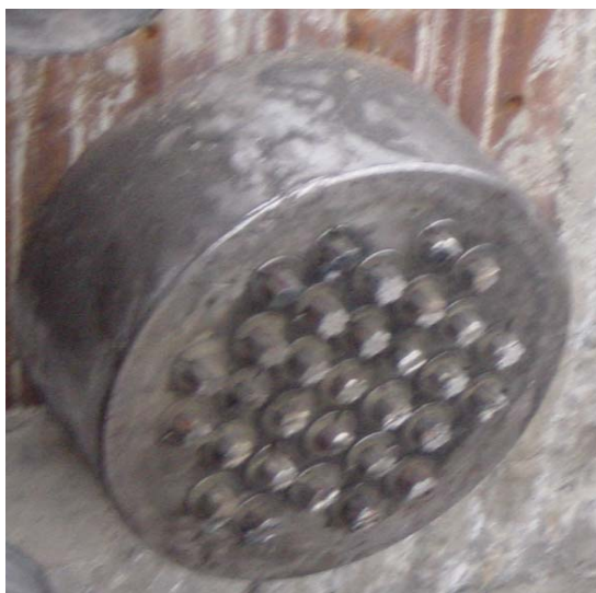
图 1 张拉后已切割钢绞线但未安装密封盖帽的锚环
