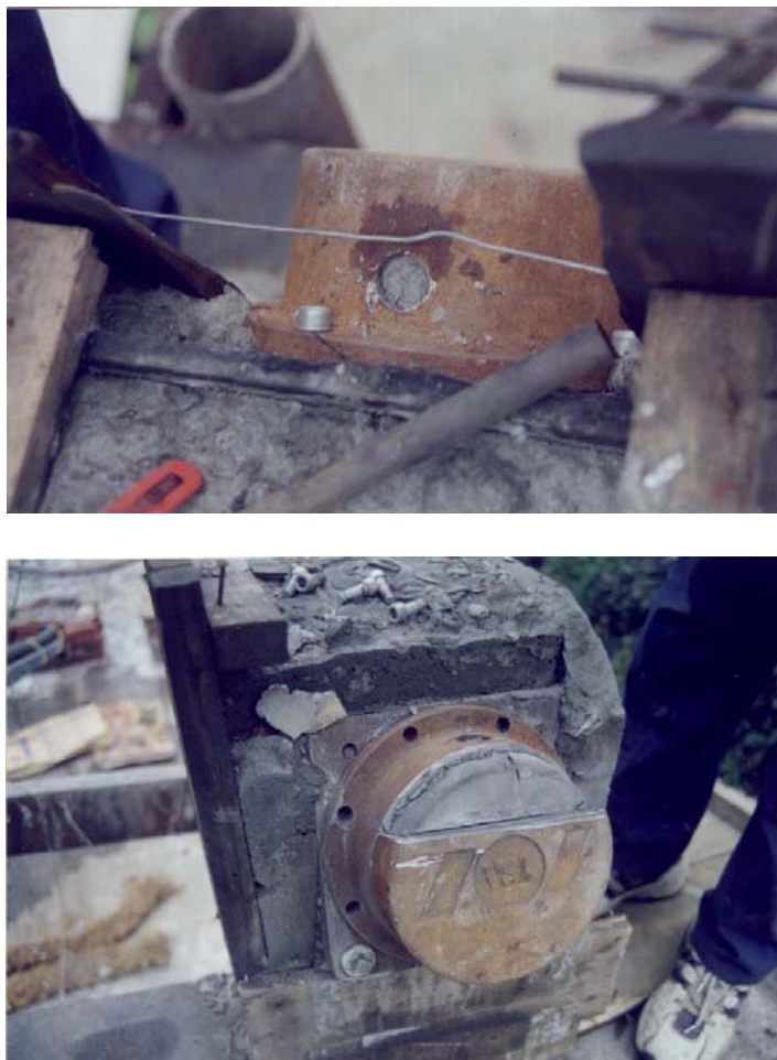
图 3：通过观察孔，检测压浆质量
