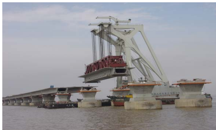
图 15 浮吊安装
