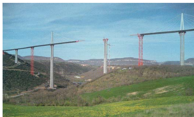
图 5 顶推施工图
