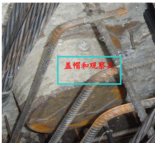
图 2：安装密封盖帽后的锚具
