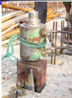
第二次张拉锚杯至设计荷载
