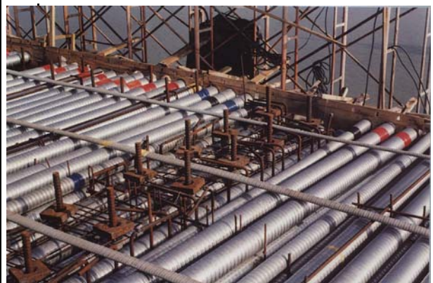
混凝土箱梁三向预应力筋布置
