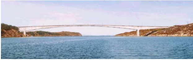
斯托尔马桥 ( L=301\text{m} ), 跨中182m为C60轻质陶粒混凝土
